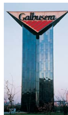
Logo továrny na cukrovinky v Agrate Brianza (Milan), Itálie, stojí na 22 m vysoké věži, obložené elektrolyticky obarvenou nerezovou ocelí.
